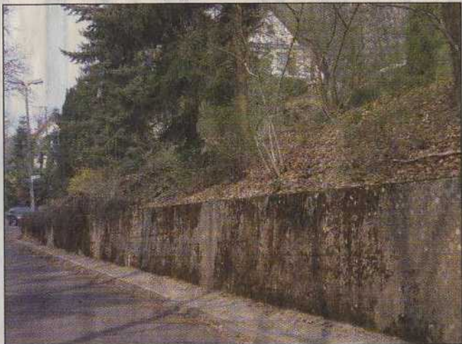
Diese triste Betonwand in der Hardt soll durch die Kinder der Grundschule farbenfroh und freundlich gestaltet werden. Foto: privat
