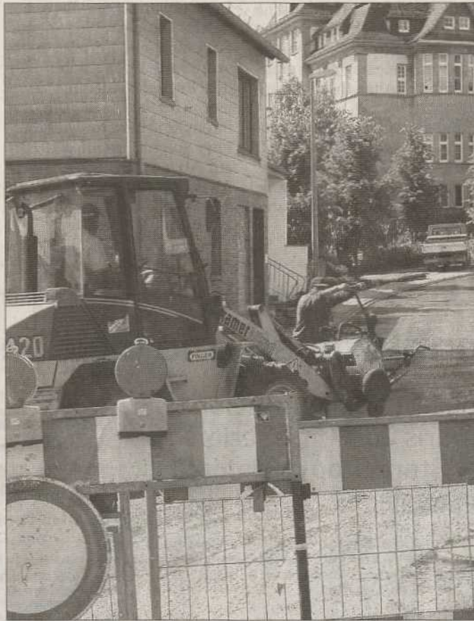
Mit einer neuen Deckschicht versehen wurde der am stärksten lädierte Bereich der Beunstraße (Foto) und ein Teilabschnitt in der Burgstraße. ■ Foto: Hans-Josef Schneider
